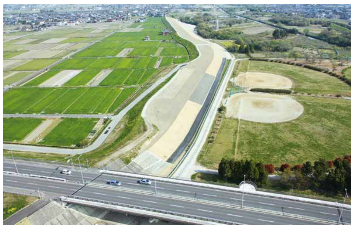
平成20年度 国土交通省発注 杭瀬川綾野築堤工事
