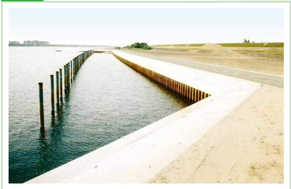
平成4年度 建設省発注 木曾川後江護岸工事
