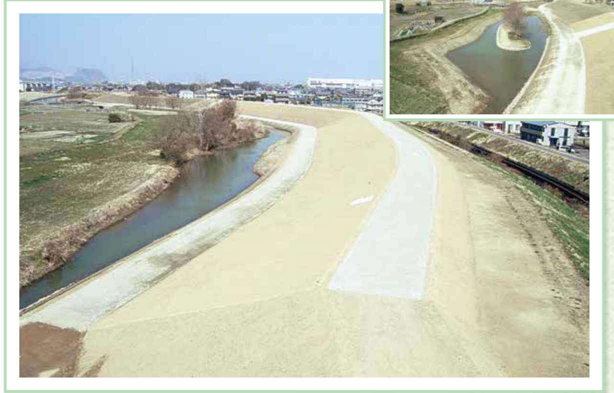
平成24年度 国土交通省発注 杭瀬川静里築堤工事
