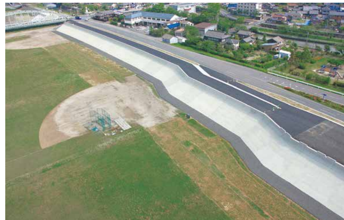
平成22年度 国土交通省発注 木曾川前ヶ須高潮堤防工事
