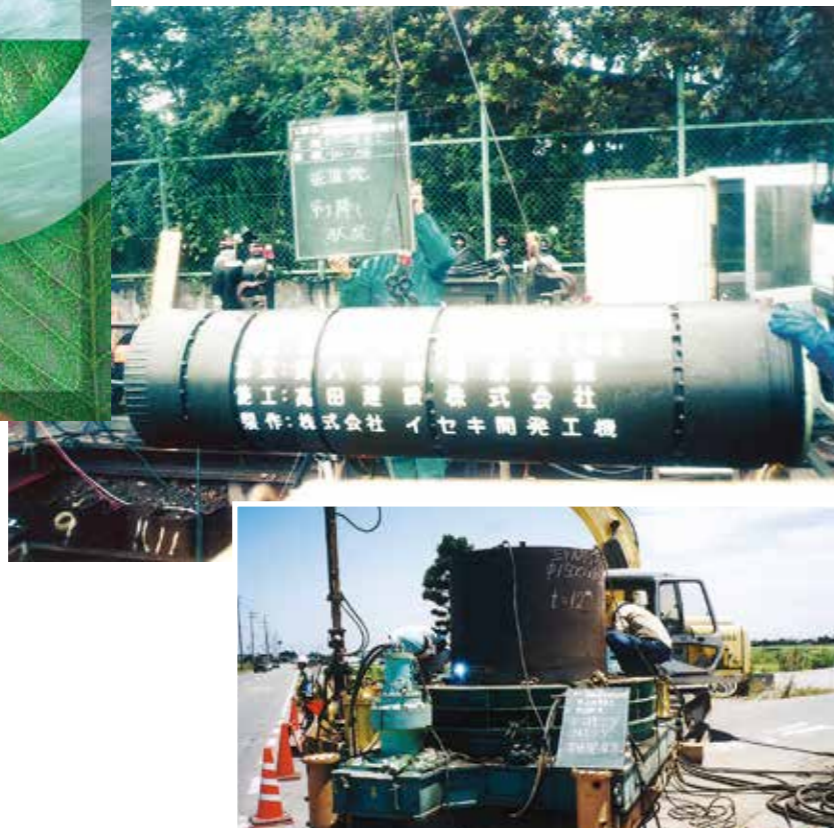
安八町発注 3号污水幹線築造工事
