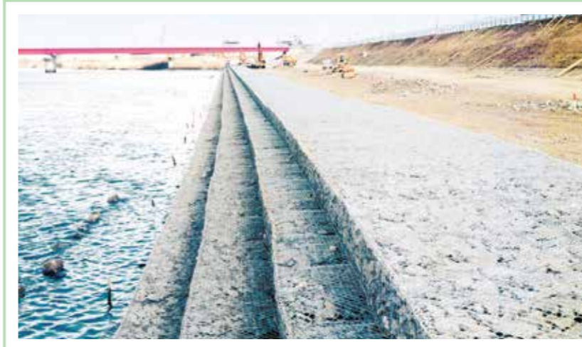
平成7年度 建設省発注 庄内川中須高水敷造成工事<クボタ建設>
