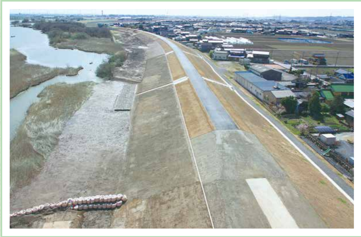
平成22年度 国土交通省発注 揖斐川田鶴護岸工事
