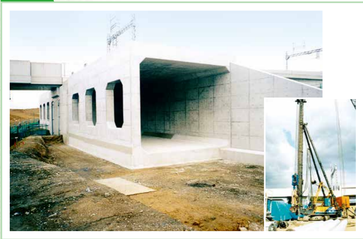
平成10年度 建設省発注 牧田川烏江函渠工事
