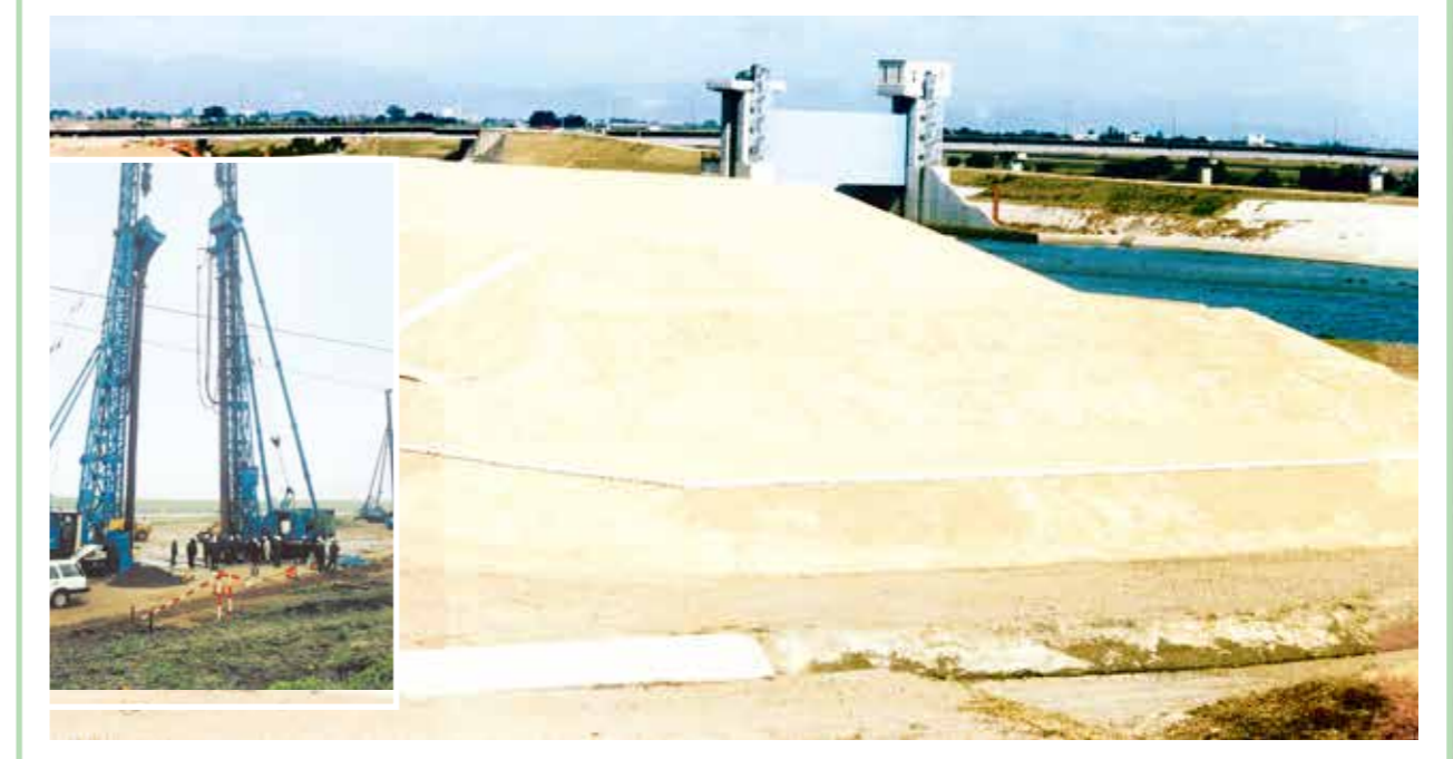
昭和62年度 建設省発注 津屋川羽沢築堤工事（地盤改良、プレロードを含む）
