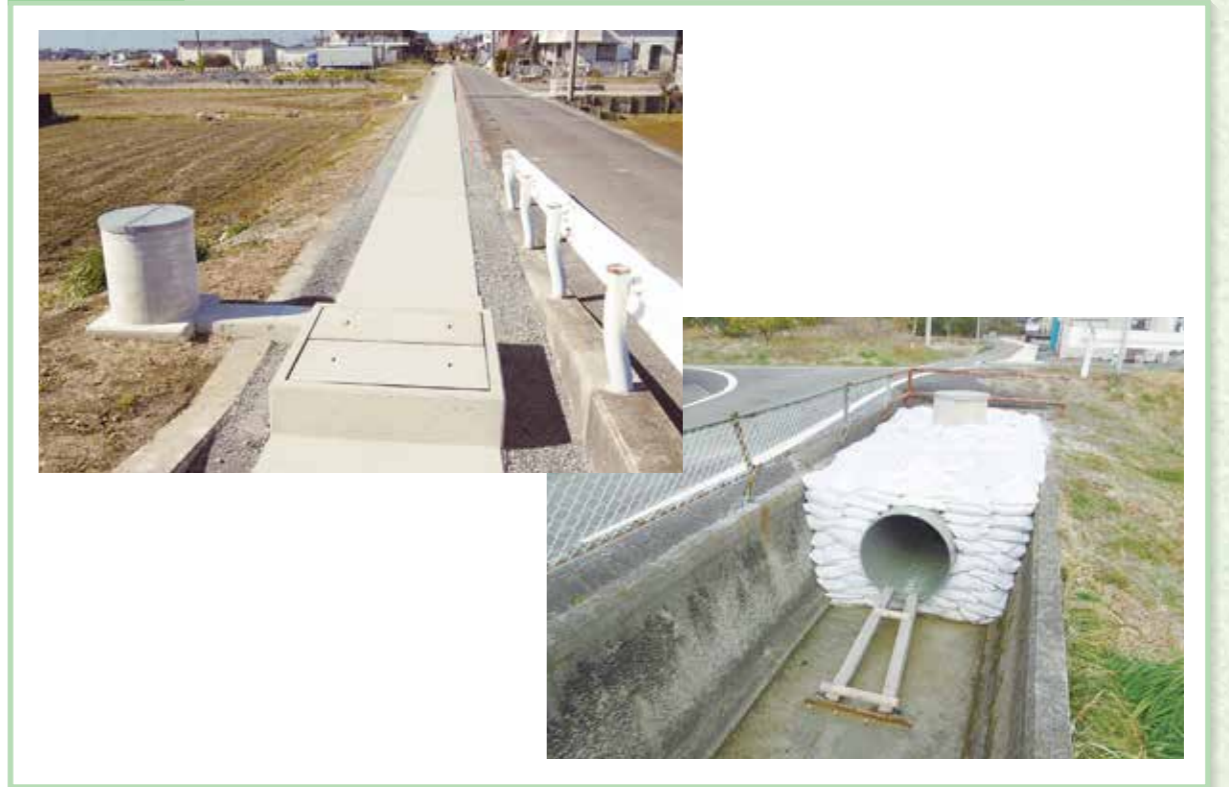
平成26年度 西濃農林事務所発注 揖斐川以東 第三期地区 第3号用水路工事
