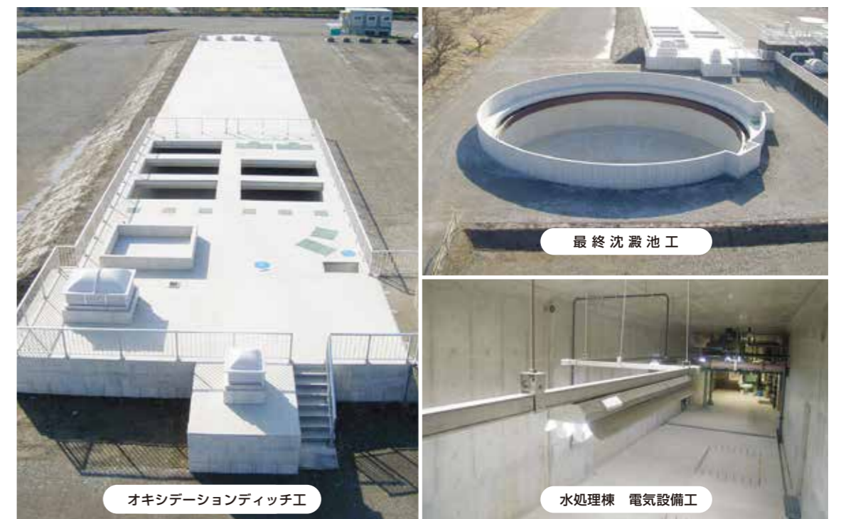
平成18年度 日本下水道事業団発注 安八町安八浄化センター建設工事その7<高田・堀JV>
