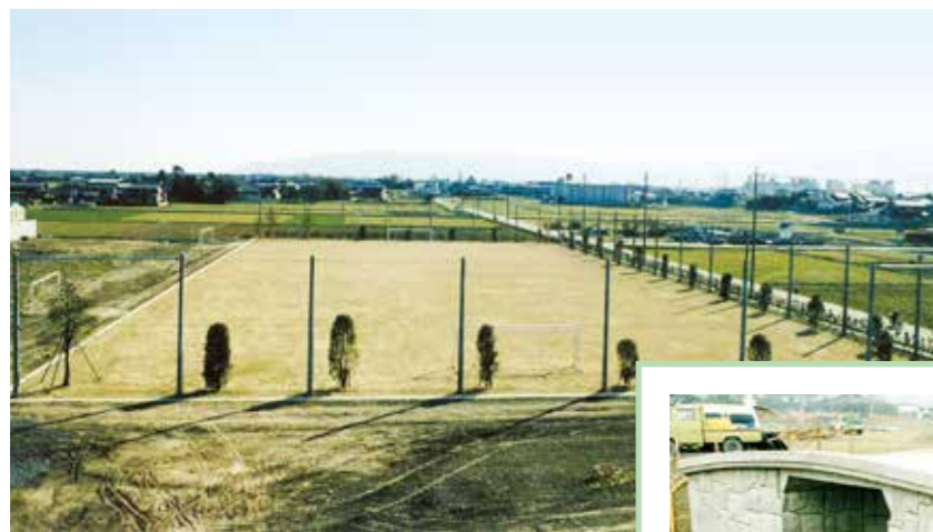
平成元年度 安八町発注 安八町総合運動公園サッカー場新設工事
