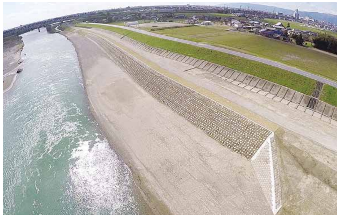
平成26年度 国土交通省発注 揖斐川津村低水護岸工事
