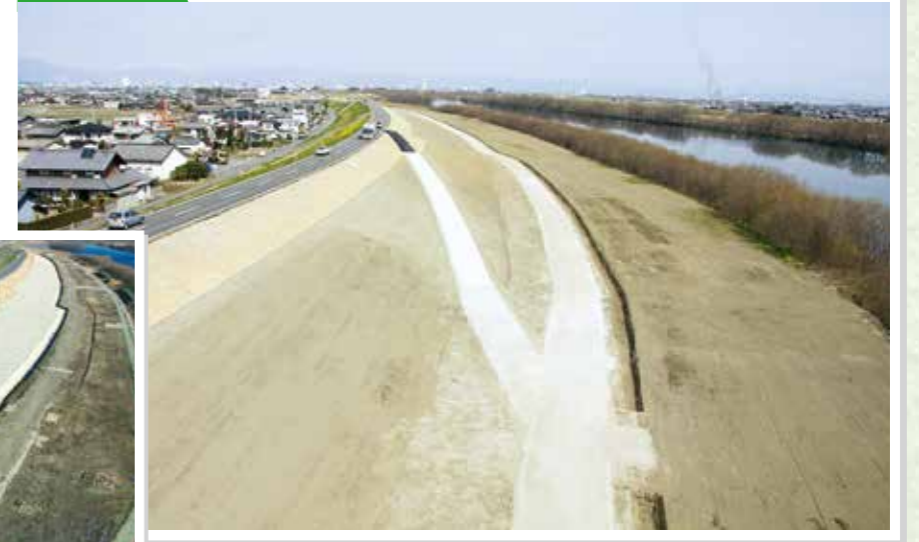
平成23年度 損斐川難波野護岸工事
