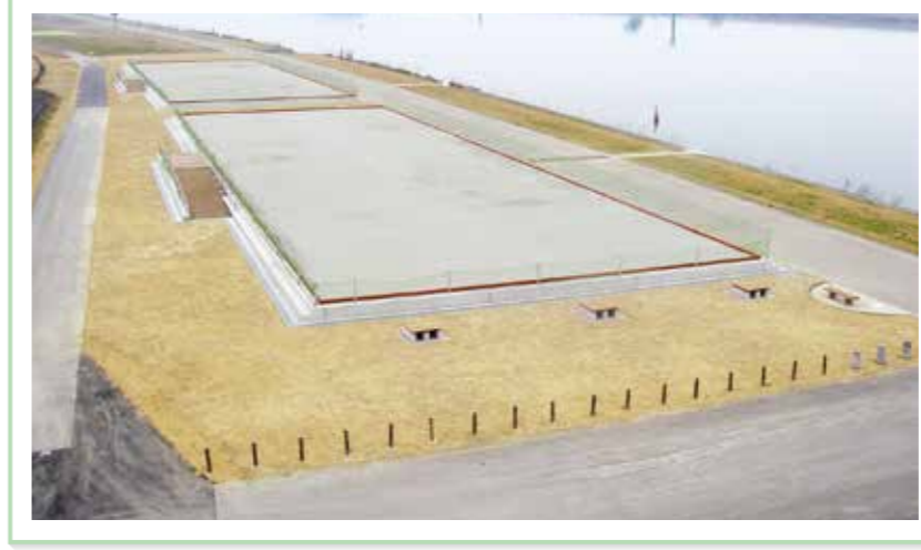
平成21年度 国土交通省発注 木曾三川公園長良川サービスセンター施設整備工事<ヤハギ緑化>
