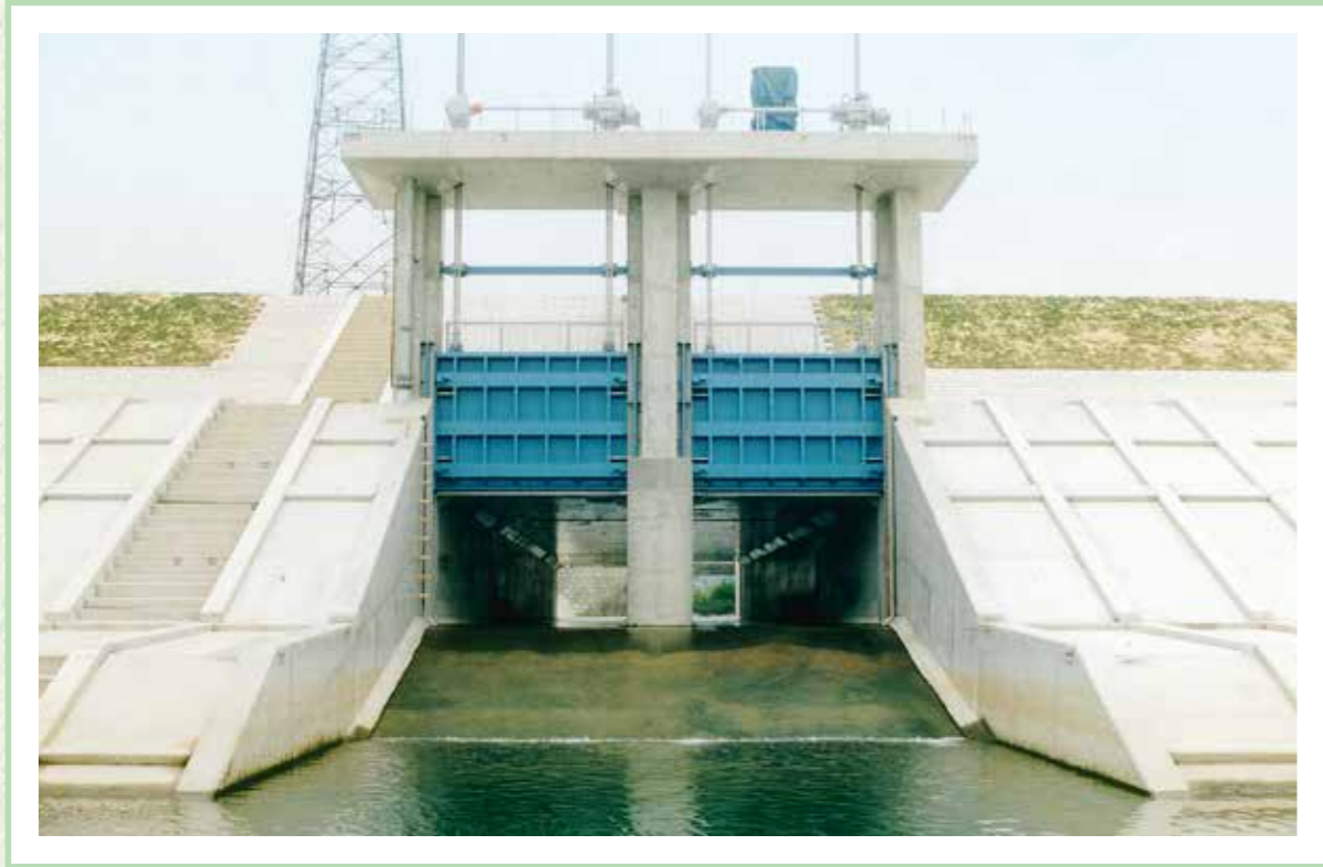
平成元年度 建設省発注 津屋川岡谷第1排水ひ管工事
